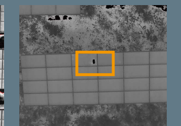
モジュール割れ
