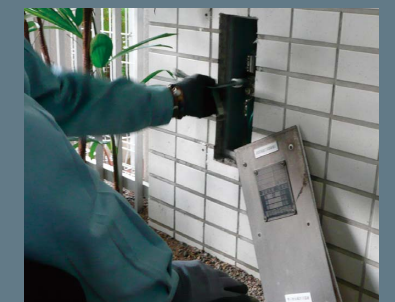
ボルトの緩み・接続異常の確認
