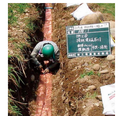
2~3日後には土中の水分により、ホクデンEP-1が凝固し、網・銅線とが一体となった導電性接地電極を形成します。
