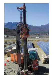
【バーカッションドリルによる掘削作業】
